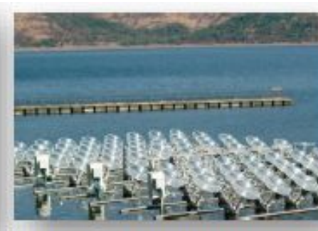
Flottant à concentration LSA (Liquid Solar Array)
